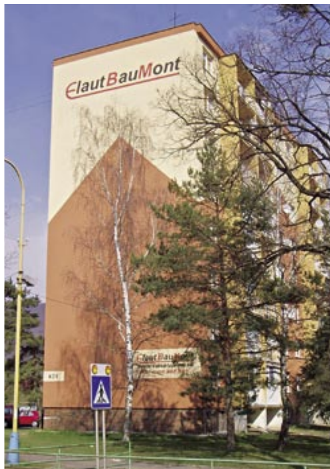
Bytový dom na Vihorlatskej ulici v Strážskom
